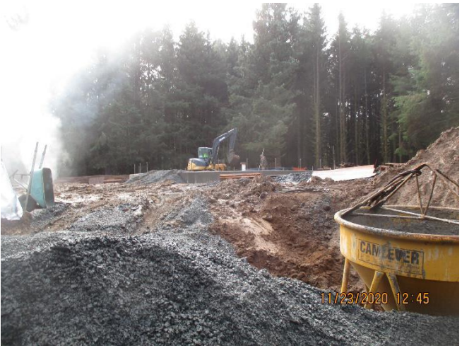
Concrete pour for ringwall for CW1
