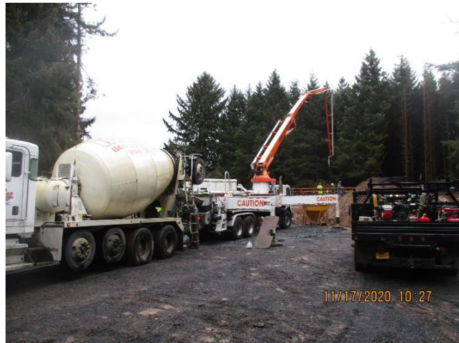
Concrete pour for ringwall footing
